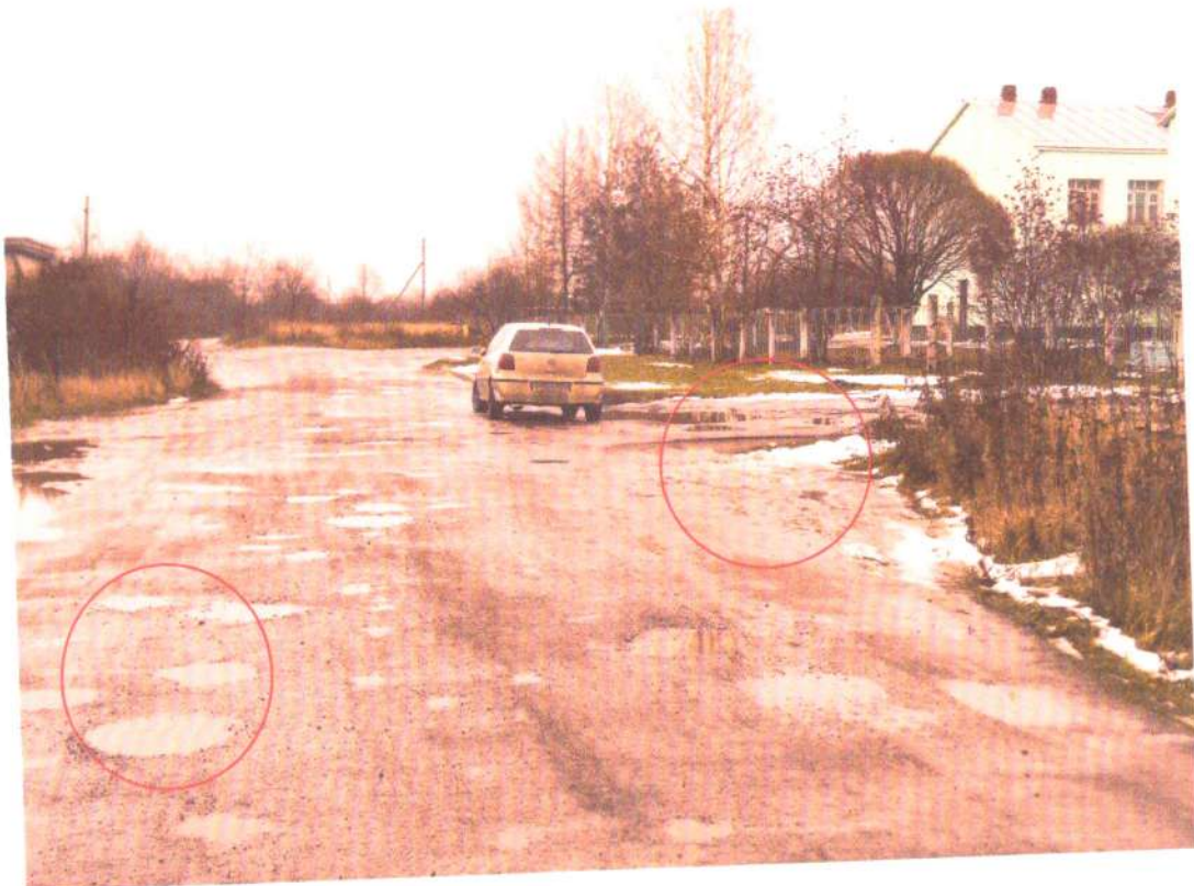
Наличие дефектов покрытия проезжей части
